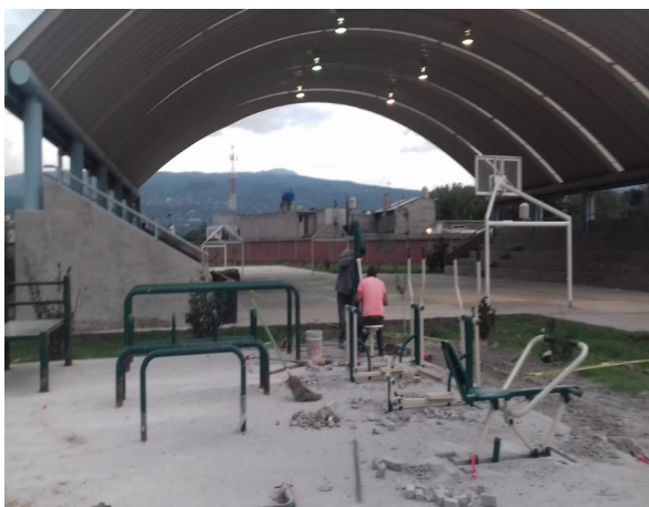
Adecuaciones al Gimnasio al aire libre
